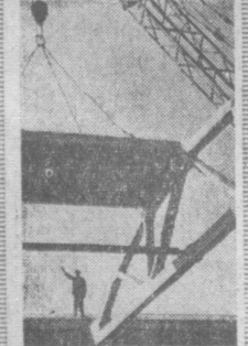
В седьмом квартале Чиланзара (Ташкент) идет строительство прачечной фабрики, рассчитанной на стирку 10 тонн сухого белья в смену. На снимке: один из участков строительства. Фото Р. ДЖУМАНИЗОВА, Ю. ТАКЕБАЕВА, А. ЦАКУБА и А. ХОДАКОВА.
