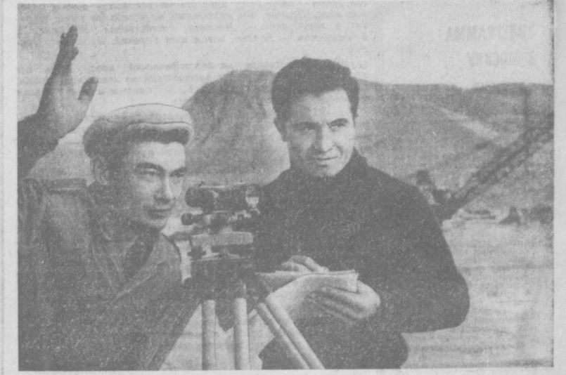
На снимке: строймастер СМУ-1 комсомолец Бахадур Фазлиев (слева) и прораб СМУ-1 коммунист Камаля Диналолов за установкой отметки на поверхности бетона. Фото А. ВОРОПАЕВА.
