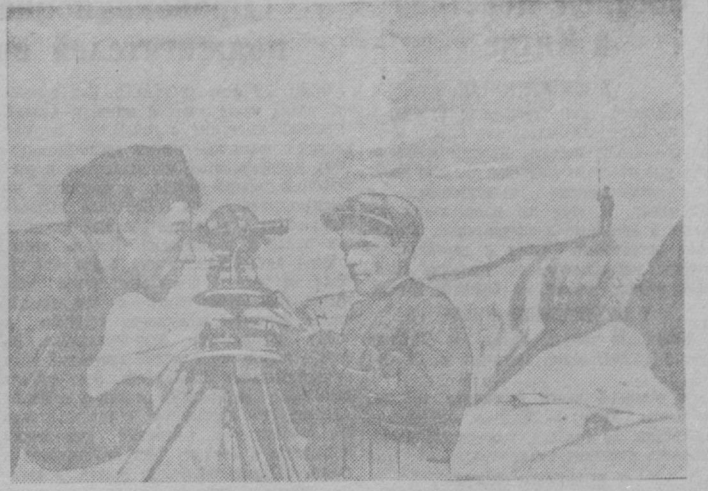
На трассе Ташкентского канала. Старший топограф Н. И. Сатурнов (слева) и техник И. Д. Чаплыгин прокладывают трассу канала в пойме реки Ангрек.
