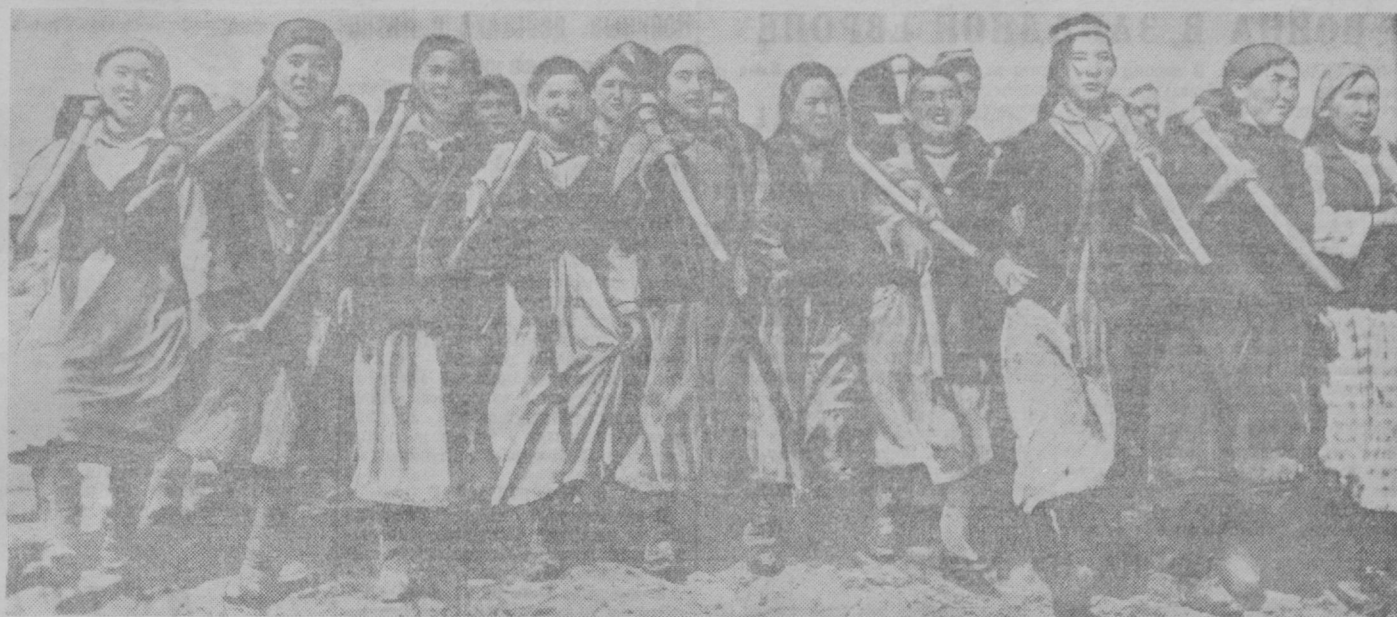
Стахановская женская комсомольская бригада колхоза «Азад», Ак-Курганского района, успешно работающая на трассе. 12-го строительного участка Ташкентского канала. Фото М. Пенсона.
