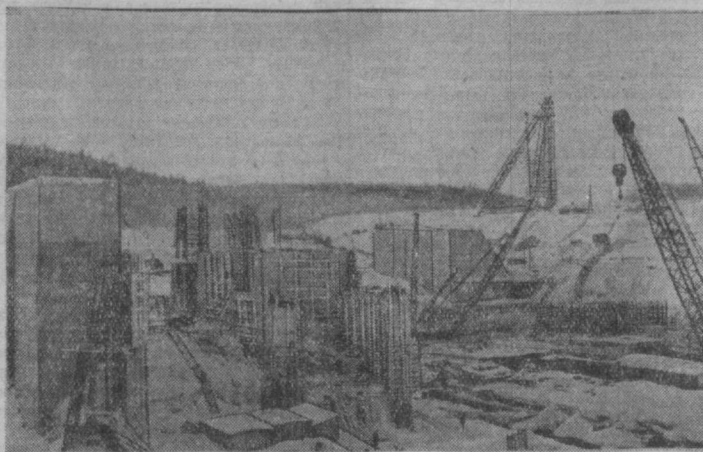
1. На строительстве Уфимской ГЭС уже обрисовались контуры будущего плотины. Сейчас здесь идут работы по установке арматуры и укладке бетона. На снимке: нижняя голова плотины Уфимской ГЭС. 2. Харьковский тракторный завод создал образец нового гусеничного трактора ХТЗ-20 мощностью 54 лошадиных силы. Трактор ХТЗ-20 может работать со значительным количеством машин и орудий и годится для использования как в сельском хозяйстве, так и на строительных работах. На снимке: новый трактор ХТЗ-20.
