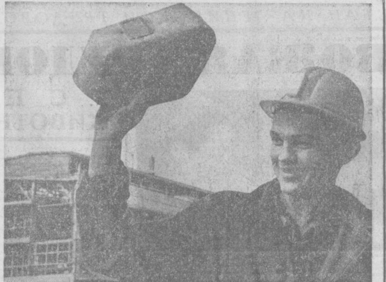
Памятным был уходивший год для участника строительства Алмалыкского химического завода Александра Кочетова — монтажника управления «Стальмонтаж». Все полученные задания им выполнены с опережением сроков: свои нормы Александр регулярно выполнял.
