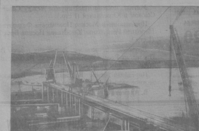
На строительстве Кайрак-Кумской ГЭС. На снимке: вид на плотину. Фото Г. Перенкина.
