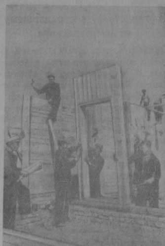
Андрей Молодець, приехавшая на строительство Большого Антрена, овладевает новыми специальностями. На снимке: комсомольско-молодежная бригада плотников, возглавляемая бригадиром-инструктором А. Д. Простяковым, монтирует сборный жилой дом.
