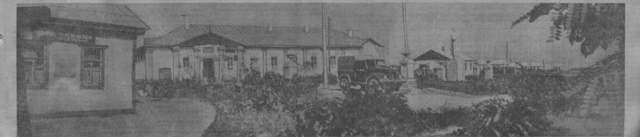
Два года назад в Голодной степи началось строительство нового колхозного поселка сельхозартели имени Ахунбаева, Сыр-Дарьинского района. Теперь хлопкоробы не без основания называют его городком. Здесь выросли добротные административные здания, жилые дома, хозяйственные постройки. Ведется прокладка водопровода. Гордостью колхозников является недавно сооруженная школа-десятилетка с просторными классными комнатами и учебными кабинетами, актовым и спортивным залами. На снимке: общий вид нового колхозного поселка. Фото П. Ковалева.
