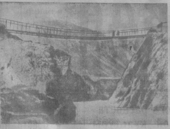
Подвесной мост через Чирчик (вблизи поселка Чарвак). Фото В. Афанасьева.
