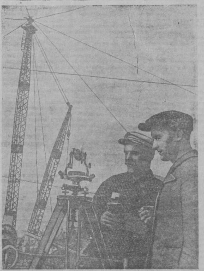
Начальник работ Ташкентской ГЭС Чирчикстроя тов. И. А. Шутинков (слева) и мастер монтажных работ тов. В. Томарев за электромонтажом фото Г. Гер.
