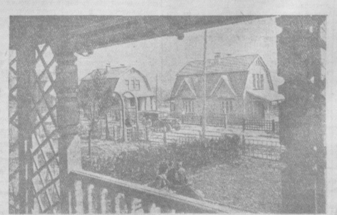
В окрестностях Киева на Багрянской горе строится большой рабочий поселок. Здесь возводятся двухэтажные жилые дома со всеми удобствами (архитектор Н. В. Холостенко). На снимке: вид на одну из улиц поселка. Фото Н. Грановского. (Фотохроника ТАСС).
