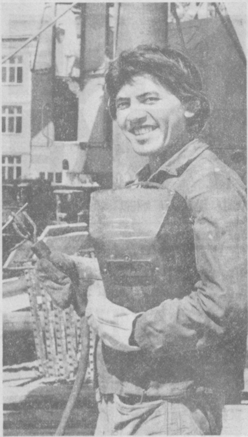
Куполообразный наземный вестибюль на станции «Дружба народов» возводит бригада Фезз Мамбетова из второго тоннельного отряда треста «Ташметрострой». В архитектуре здания учтен национальный колорит. Предусмотрены социальные устройства, с помощью которых летом в помещении будет сохраняться прохлада. В эти дни ведется монтаж унифицированной железобетонной опалубки весом 130 тонн. Полностью строительство решено завершить за 4 месяца, на 2 месяца сократить запланированный срок. За этот период будет сварено 680 кубометров железобетона, строительно-монтажных работ выполнено на 240 тысяч рублей. На этом снимке вы видите передового электросварщика Марата Юнусова. Сменные задания он регулярно выполняет.
