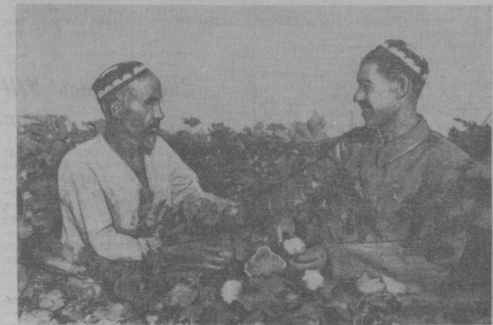
В колхозе имени Сталина, Андижанского района, началось раскрытие корбачек хлопка. На снимке: Герой Социалистического Труда, звеневый А. Маматалиев (справа) и подвальный С. Мамадалиев осматривают поле. Фото Н. Сабирова. (Фотохроника УзТАГ).
