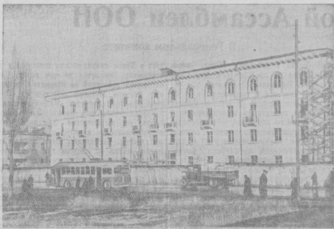
Во Фрунзенском районе Ташкента заканчиваются отделочные работы в новом многоквартирном жилом доме на улице Богдана Хмельницкого. Фото А. Аверьянова.
