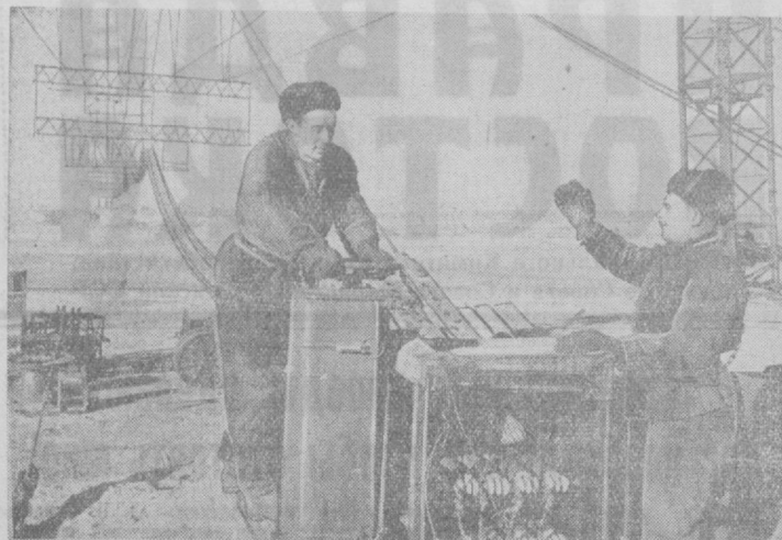
Сталинградгидрострой. На строительстве подвесной канатной дороги через Волгу закончен монтаж нижнего вантажного перехода. На снимке: установка электрической лебедки сетевых канатов на якорь. На переднем плане — монтажники-верхолазы В. И. Карлов (слева) и бригадир монтажников Н. П. Клинов. Бригада выполняет месячную норму до 180 процентов. Фото А. Маклецова (Фотохроника ТАСС).
