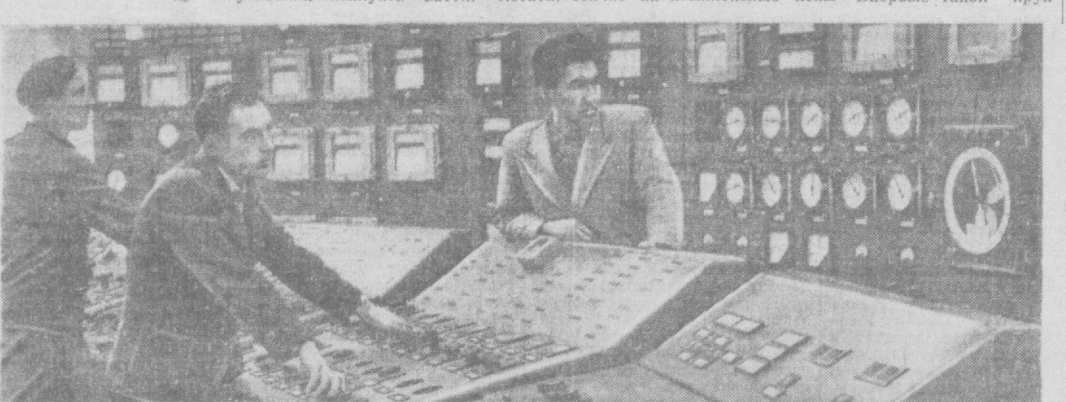
У пульты управления Ташкентской ГРЭС. Слева направо: машинист котла-блока Н. Ф. Иванов, машинист блока А. П. Пуговцев, дежурный инженер К. Абдуразаков.
