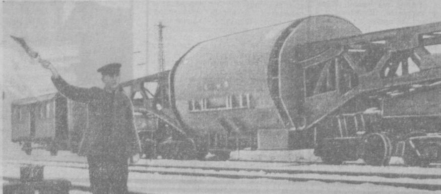
В народной Германии намечается дальнейший рост энергетических мощностей. Общая мощность агрегатов, которые вступают в строй на сооружаемых и действующих электростанциях, составляет более 300 тысяч киловатт. На снимке: статор турбогенератора мощностью 150 тысяч киловатт, доставленный по железной дороге с ленинградского завода «Электросила». Он будет установлен на Дунайской тепловозоэлектроцентрали в Сахалинске.
