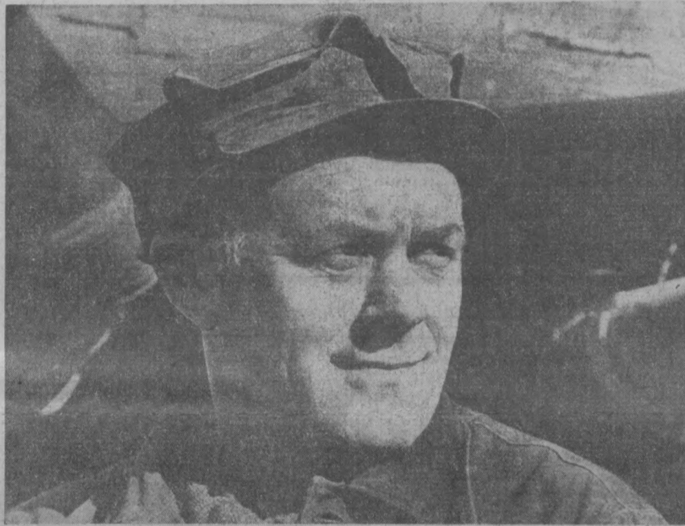
Бригада монтажников, которую возглавляет запечатленный на этом снимке Михаил Иванович Калашников, сооружает арматурный каркас турбинного водовода Чарвакской ГЭС. Еще в минувшем году передала бригада строки начала трудиться в свет нынешнего, 1970 года.
