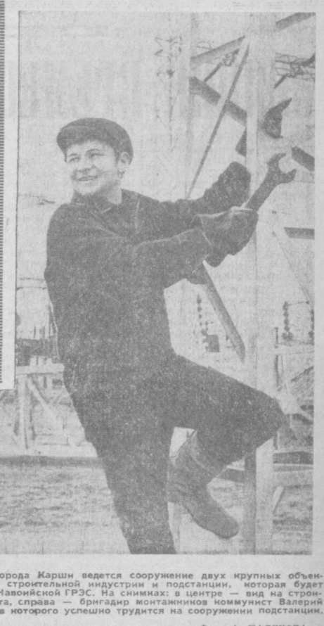
В окрестностях города Марши ведется сооружение двух крупных объектов — комбината строительной индустрии и подстанции, которая будет питаться током из вышестоящей ГРЭС. На снимках: в центре — вид на строительный комбинат, справа — бригадир монтажников коммунист Валерий Тарасов, коллектив которого успешно трудится на сооружении подстанции.
