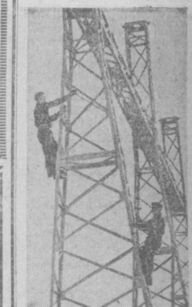
В районе Ташкентской ГРЭС. Машинисты высоковольтной линии электрораздачи.
