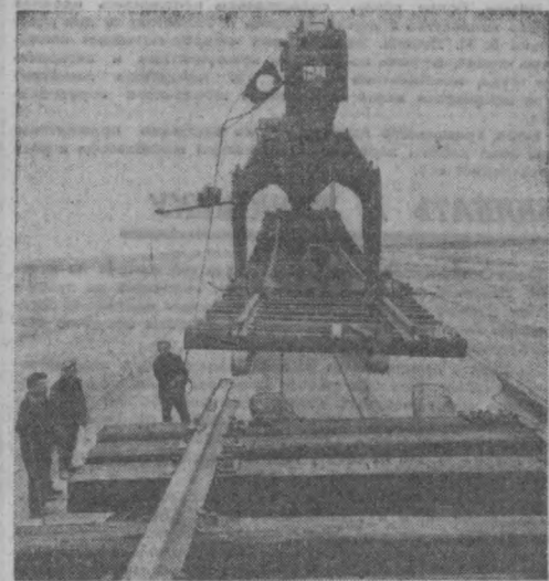
На строительстве магистрали Кунград — Бейнеу укладываются последние километры железнодорожного пути. Фото А. ЛИХВАРИ.
