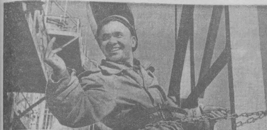
Быстрыми темпами ведутся строительные работы и монтаж оборудования второй очереди сернокислотного цеха Алтынтюпканского свинцово-цинкового комбината имени Ленина. На снимке: лучший электромонтажник Илья Гуляжанов, ежедневно перевыполняющий производственные задания.
