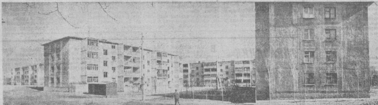
Строители Ноканда быстрыми темпами возводят десятки новых благоустроенных домов. На снимке: новый дом на улице Строительной.
