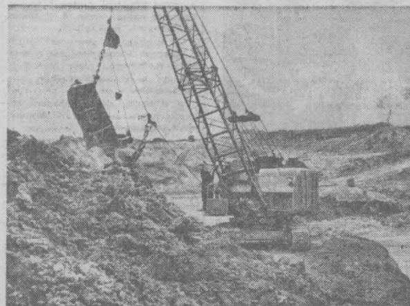
Полным ходом идет строительство Бекабской насосной станции в Каракалпакской АССР. Три ее агрегата будут давать 60 кубометров воды в секунду. Станция предназначена для подпитывания ирригационной системы имени В. И. Ленина — основной артерии хлопковых и рисовых плантаций левобережья Аму-Дарьи. На снимках: слева — земляные работы на строительстве станции; справа — передовой сварщик Климент Михалюк.
