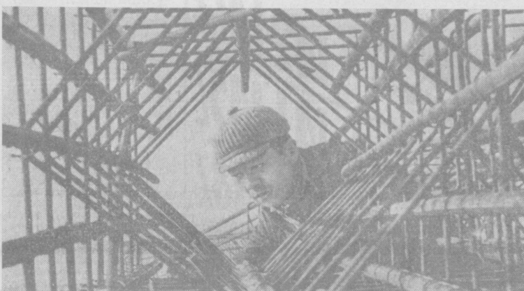
В Ташкенте, на проспекте имени Ленина, строители СУ-17 треста «Высострой» возводят 115-квартирный жилой дом. Они обещались сдать здание под отделку ко дню открытия съезда партии. На снимке: монтажники Сергей Ким за вязкой арматурного каркаса. В Ургенчском городском узле связи завершается монтаж новой городской телефонной станции. Работы ведут монтажники Ташкентского специализированного строительного управления связи треста «Узбексвязстрой». Станция будет сдана в эксплуатацию досрочно, ко дню открытия XXIV съезда КПСС. На снимке справа — комсомолка Татьяна Новикова ведет монтаж кроссировки на промшпите.
