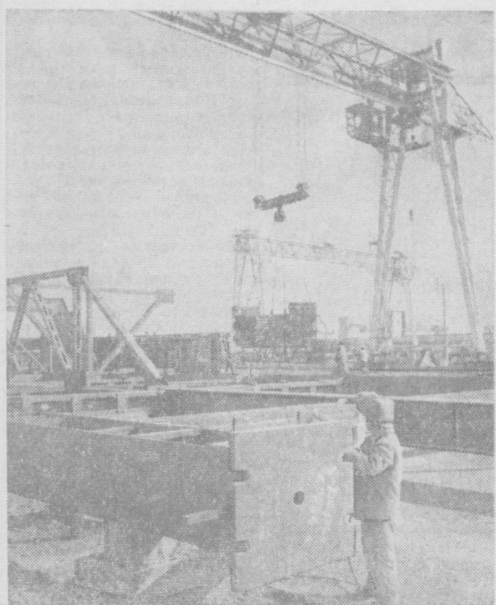
В проекте Директив XXIV съезда КПСС предусмотрено строительство в Голодной степи крупнейшей в Средней Азии Сырдарьинской ГРЭС. На снимке: на сборочной площадке ГРЭС.
