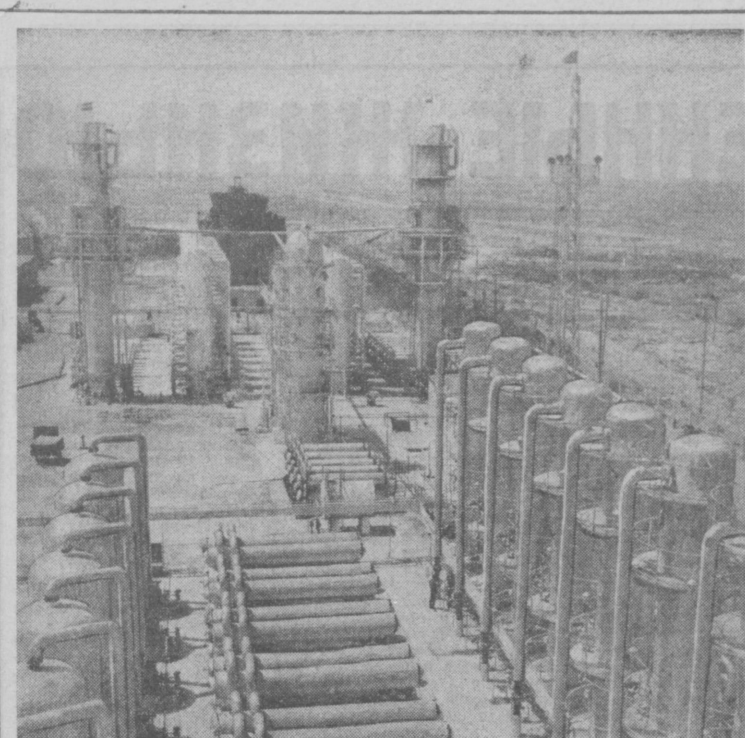
27 миллиардов кубических метров «голубого топлива» дает стране в год Газлайкское месторождение. Отсюда природный газ Узбекистана по магистральному газопроводу идет на предприятия индустриального Урала, в столицу нашей Родины — Москву. На снимке: головные сооружения газопровода Бухара — Урал — Средняя Азия — Центр. Фото А. УСМАНОВА. (УзТАГ).
