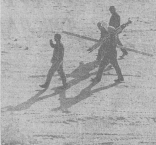
В Хорезмской области на реке Аму-Дарья успешно идет строительство одного из крупнейших в Средней Азии мукомольного гидроузла. Работы ведет управление «Тотмунгидрострой». На снимке: изыскатели на одном из участков строительства.
