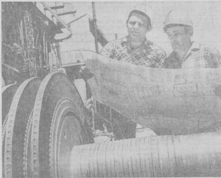
На Ташкентской ГРЭС ведутся монтажные работы по установке последнего, двенадцатого энергоблока. Слесари-турбинисты, бригаду которых возглавляет А. И. Гуляев (справа) и шеф-инженер Харьковского турбинного завода Е. С. Шевченко за работой.
