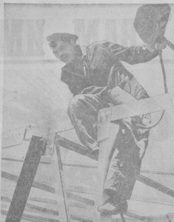
Скоро освоители безкрайних просторов Каршинской степи получат энергию Новойской ГРЭС. Оперы высоковольтной линии электропередачи «шашоты» в Кашкарскую область. Их устанавливает коллектив механизированной колонны № 48. На снимке: передовой сварщик Виктор Шилов.
