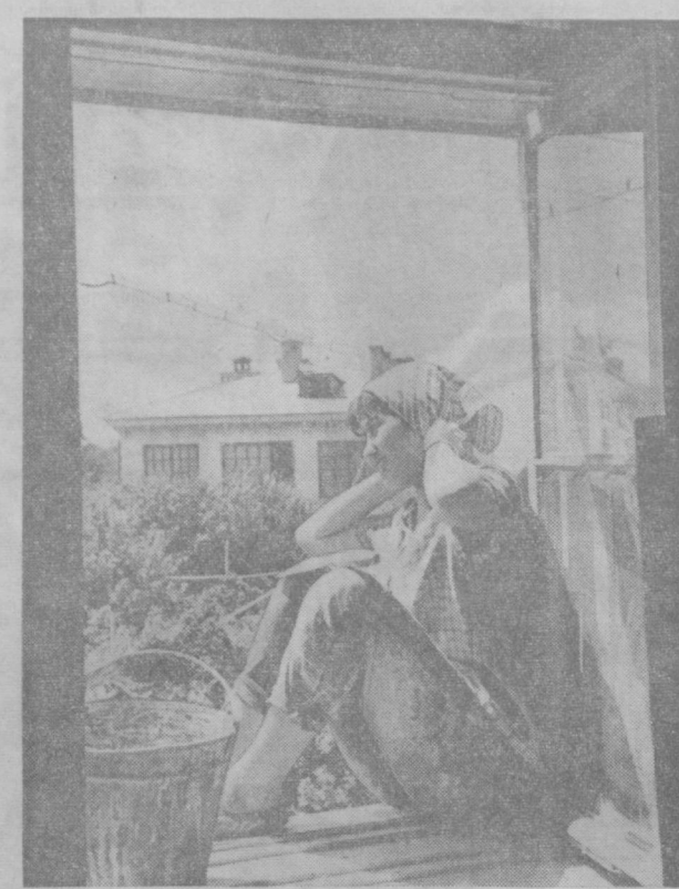
Хорезская область. Ташкент. Тюрки, которую вы видите на снимке, самый молодой класс бригады коммунистического труда штукатура строителя № 167. Девушка пришла в бригаду два года назад после окончания восьми классов. Сейчас она хороший штукатур, значительно перевыполняет норму выработки.
