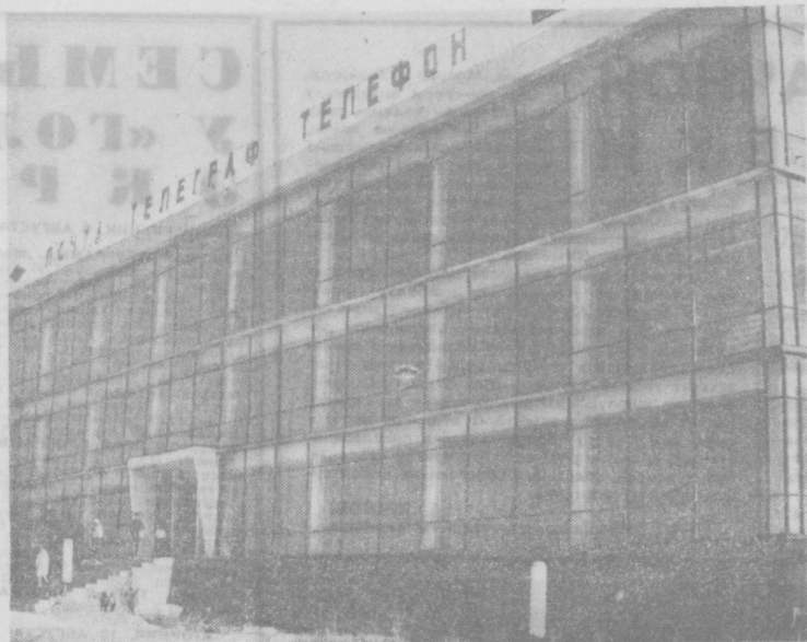
Рядом с древней Бухарой, памятники которой насчитывают сотни лет, вырос новый город. Для бухарцев здесь построены жилые микрорайоны и воздвигнуты административные здания. К услугам новоселов — газ, электричество, водопровод, горячая вода, телефон, радио и телевидение. Такие дома «выпускает» специальный крупнопанельный домостроительный комбинат. На снимке: новый Дом связи.
