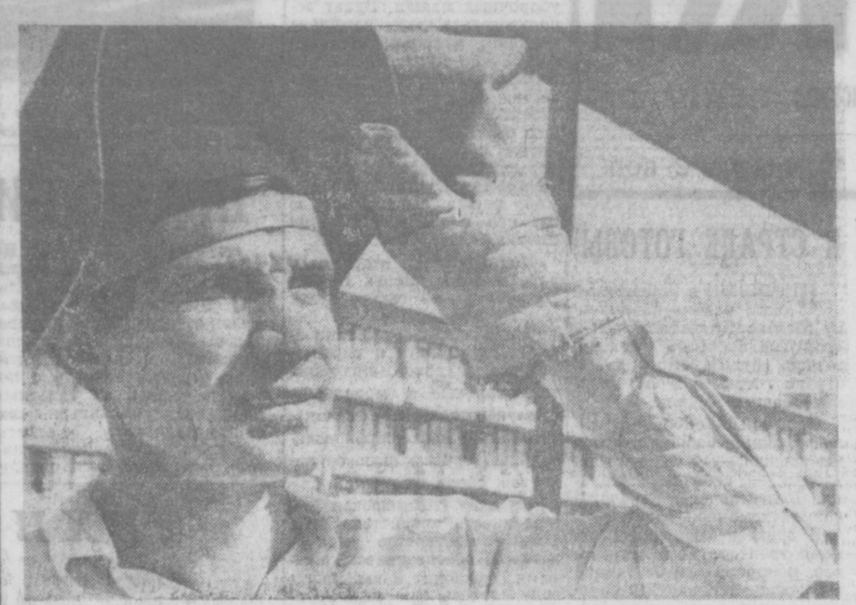
Владимир Шабардин — один из лучших электросварщиков СУ-1 треста № 153. Сейчас он работает на строительстве центра НОТ и второго здания института «Узгипроэлектромаш» в Ташкенте. Фото Л. ПЛАУБЕРГА.
