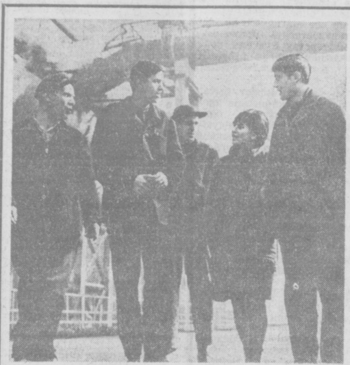
НАРОДНАЯ РЕСПУБЛИКА БОЛГАРИЯ. Кремниевый металлургический комбинат близ Софии — основное предприятие черной металлургии страны, которое называют «предприятием полного цикла». Его строительство осуществлялось при техническом содействии Советского Союза. На снимке: рабочие доменного цеха после смены.
