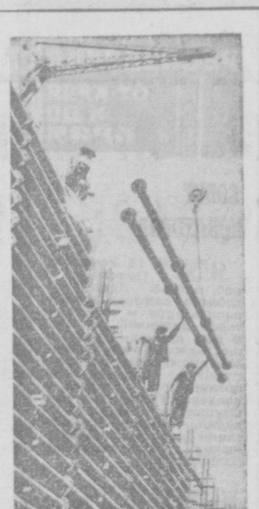
БОЛГАРИЯ. В Днепро-вской долине с помощью Советского Союза, Венгрии, ЧССР и ГДР сооружается завод, наладивший производство соды. Это будет самое крупное предприятие подобного рода в Европе. На снимке: один из участков строительства завода.
