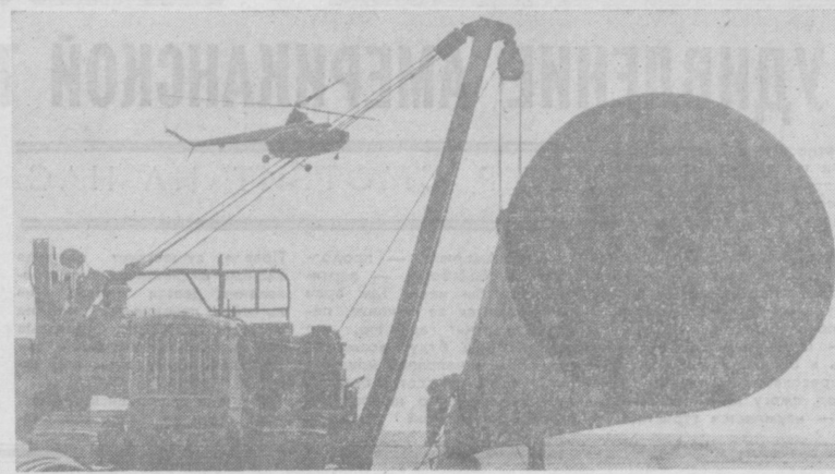
В песках Каракумов заканчивается строительство третьей очереди газопровода Средняя Азия — Центр. На снимке: укладка труб на одном из участков строительства. Фото Р. ДЖУМАНИЯЗОВА.
