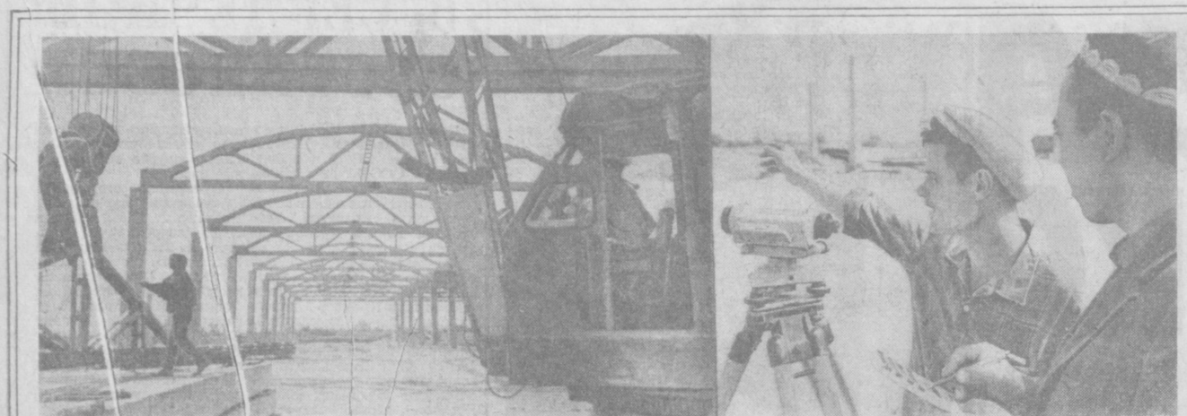
В Намангане начато строительство экспериментального трансформаторного завода. Здесь будут изготавливаться calorifеры для сельского хозяйства. Емкостью завода будет выпускаться продукция на 40 миллионов рублей. На снимках: слева — монтаж главного корпуса; справа — прораб У. Садродинов и бригадир комплексной бригады В. Ильясев.
