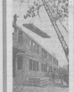
В колхозе «Коммуна» Пахтабадского района ведется большое жилищное строительство, возводятся детские сады и ясли, культурные и медицинские объекты. На снимке: строительств в школе на 320 учащихся.
