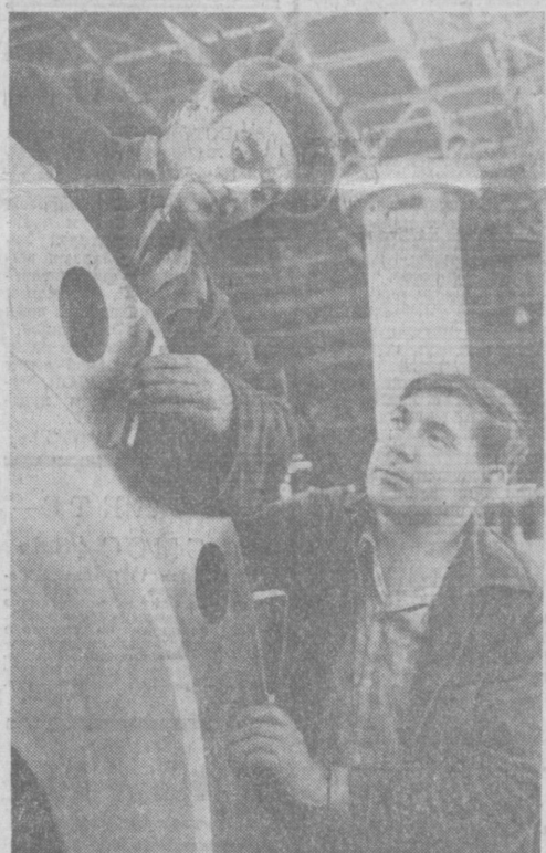
Завершили досрочно монтаж третьей турбины Чарвакской ГЭС, коллектив слесарей-турбинистов приступил к монтажу четвертой турбины. Завершить монтаж ее коллектив также намерен досрочно. На снимке: передовые слесари-монтажники В. Ф. Хомутов и Н. И. Колесников за обработкой вала генератора четвертой турбины.
