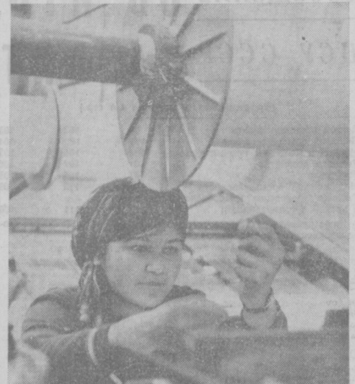
На любой стройке успех дела во многом зависит от бесперебойной работы транспорта... Фото А. ХОДАКОВА и А. ПАЛЕХОВА.
