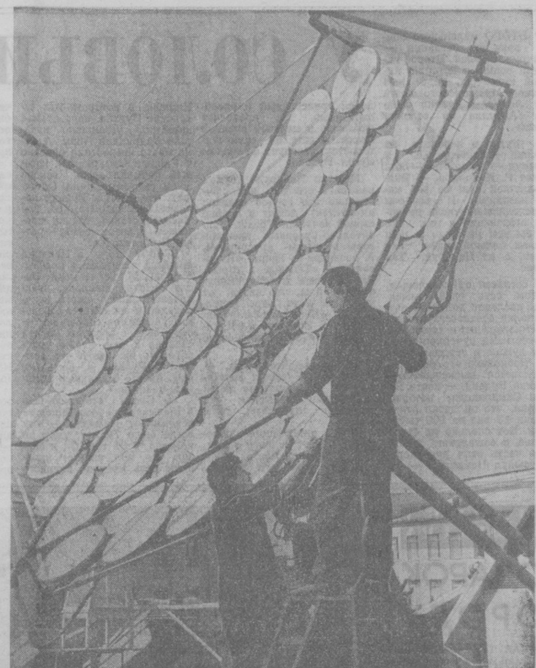
В Физико-техническом институте имени В. С. Староверова Академии наук Узбекистана ССР ведут работы по созданию и внедрению установок по использованию солнечной энергии в народном хозяйстве. На снимке: подготовка одной из установок солнечного концентратора к работе.
