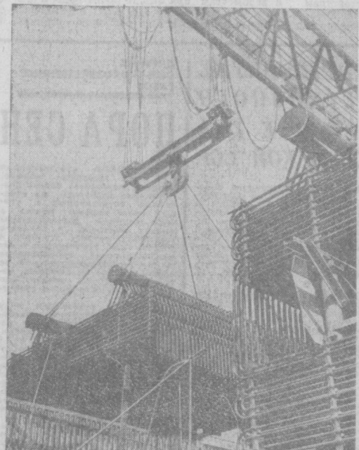
Строители и монтажники Сырдарьинской ГРЭС соревнуются за сдачу в эксплуатацию второго энергоблока мощностью 300,000 киловатт к празднику Октября. Многие рабочие систематически выполняют сменные задания. Среди них — слесари-монтажники Пазарь Хам, которого вы видите на верхнем снимке. На снимке слева — на монтажной площадке оборудования второго котлоагрегата.
