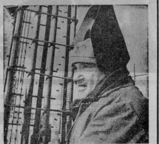
В Нукусе начато строительство одиннадцатитажной гостиницы. Ведет его коллектив строителей № 166. На снимке: передовая сварщица СУ-1 треста Роман Нурумухамедов. Фото А. ЛИХВАРИ, «УзТАП».
