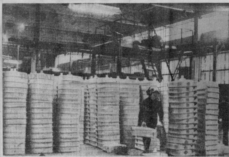
Досрочно отправлена на КамАЗ первая партия заказа, выполненная Ахангарским заводом Сантехлит. Это — чугунные трубы, применяемые при сооружении бытовых предприятий, и коммуникации водной магистрали. Заказ этой крупнейшей стройки страны колхозники завода будут выполнять в течение всего текущего года. На снимке: в одном из цехов завода.
