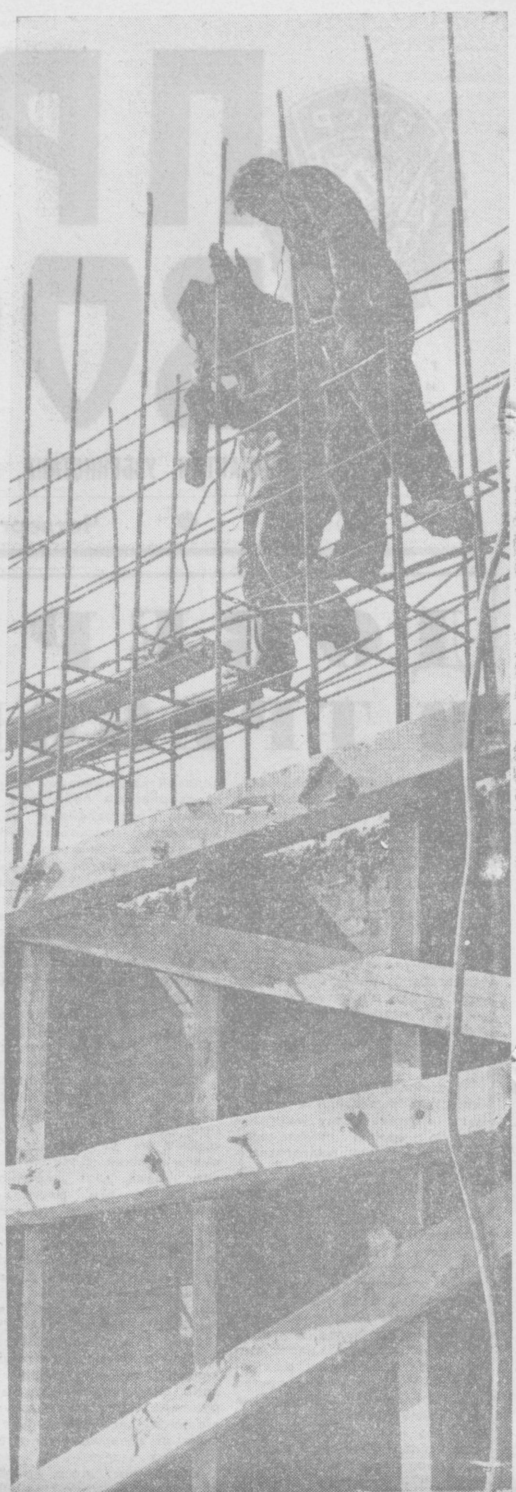
Монтаж арматуры на гидросооружениях Языванском. Фото В. ДМИТРИЕВА.
