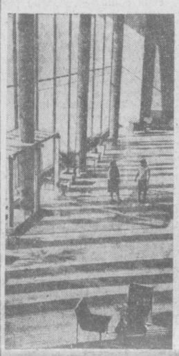
В Ташкентском аэропорту выстроено новое здание, аэровокзал. На снимке вы видите вестибюль этого сооружения.
