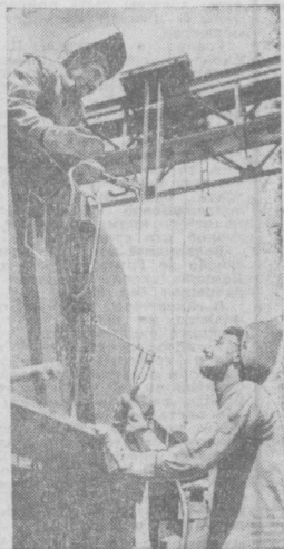
Тысячи тонн металлических конструкций сварили за время работы на строительстве Чарвакской ГЭС электросварщики Геннадий Максимов и Виктор Паньков.
