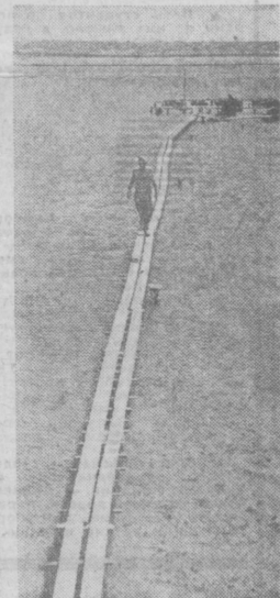
В революционном совхозе «45 лет ВЛКСМ» работает опытно-балансовый участок Каракалпакской гидроэлектростанции. Научные работники ведут исследования по определению величины испарения и расхода влаги при поливе растений. На этом снимке вы видите один из участков станции.
