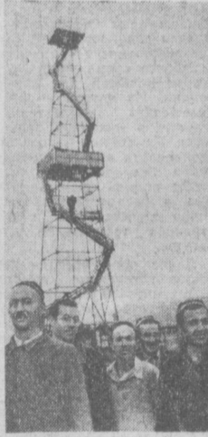
С оперением графиня работала на буровой № 24 участка «Ишуд» Намаганской области объединения «Узбекнефтегаз» коллектив: возглавляемый бурьяльщиком Мамадали Касымовым. На снимке (слева направо): Мамадали Касимов, помощник бурьяльщика Хасанбай Джурбаев, электромонтер Каримжан Туляев, помощник бурьяльщика Артын Тажидбаев и помощник бурьяльщика Атабай Тургунов.
