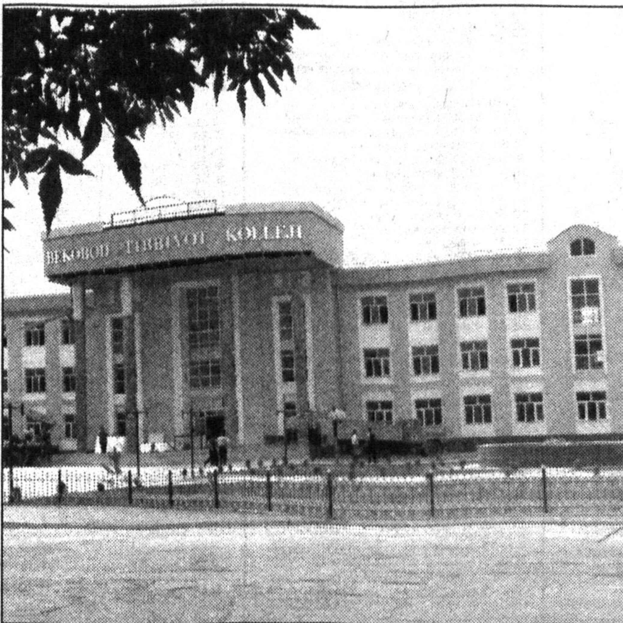
На снимках: идет строительство Бекабадского профессионального медицинского колледжа; монтажники Шухрат Маматкулов и Гуломжон Азимов.
