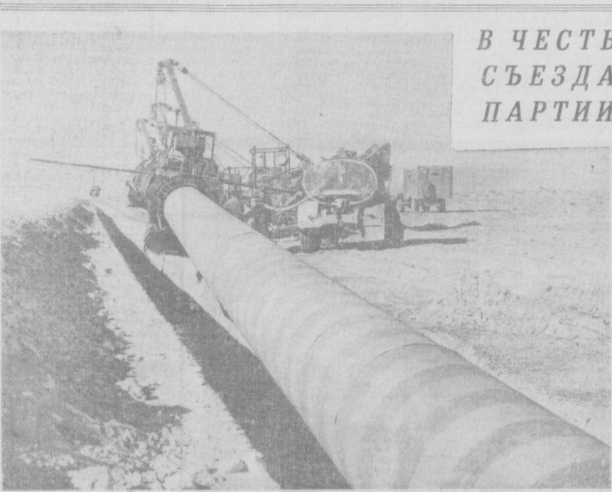
С каждым днем, приближающимся к знаменательному событию в жизни партии и страны — XXIII съезду КПСС, строители наращивают темпы работ на сооружении третьей очереди газопровода Бухара — Урал. На снимке: на одном из участков строительства газопровода.
