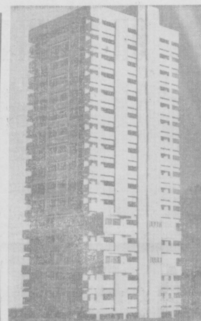
Вот такие шестнадцатиэтажные дома вырастут в недалеком будущем в Чиланзарском районе Ташкента. Макет одного из них вы видите на нашем снимке. Дома будут возведены из сборных элементов каркаса и легких стеновых панелей, изготовленных заводским способом. В каждом высотном доме разместится 64 квартиры с несколькими балконами, кондиционированной и в воздухе, раздвижными перегородками, позволяющими изменять планировку жилища. Авторы проекта — архитекторы И. А. Абдуллоев, С. А. Розенблюм, инженеры Е. Е. Семенов и А. А. Коржов из Ташкентского зонального научно-исследовательского и проектного института типового и экспериментального проектирования жилых и общественных зданий.
